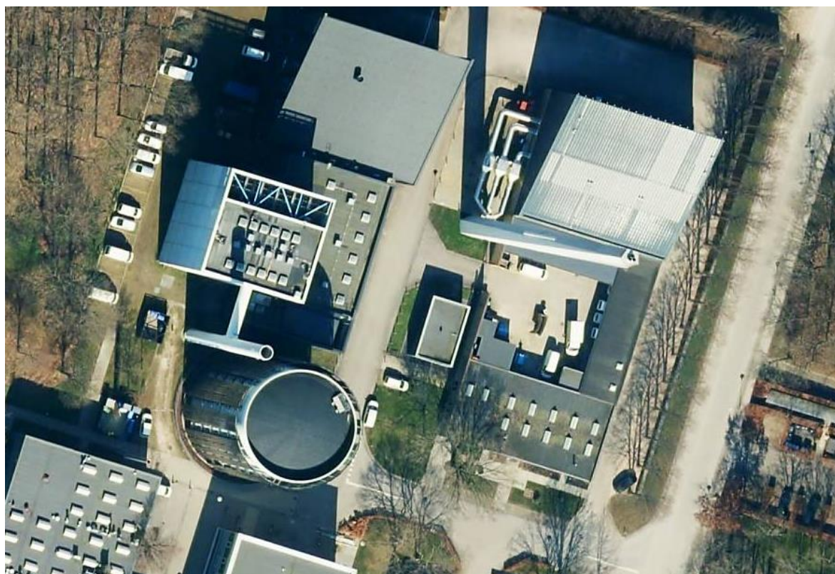
Figur 6-11 Vestforbrændings anlæg på DTU kan udbygges yderligere
